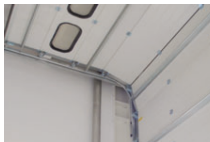
Refuerzo interior del panel
